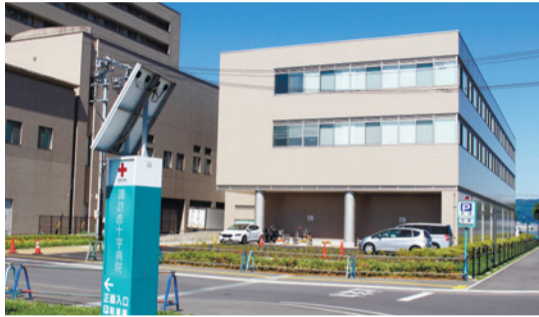
諏訪赤十字病院と、地下に地中熱設備が設置された前面道路 *常時、産出されるエネルギーの高さ
